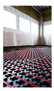
L'IMPIANTO DI RISCALDAMENTO SARÀ CENTRALIZZATO CON GENERAZIONE IN POMPA DI CALORE ELETTRICA ARIA/ACQUA SUPPORTATA DA CALDAIA A GAS CON CONTABILIZZATORI PER LE SINGOLE UTENZE ADATTA ANCHE ALLA PRODUZIONE DI ACQUA CALDA PER USO SANITARIO. L'EMISSIONE DEL RISCALDAMENTO AVVERRÀ CON SERPENTINE A PAVIMENTO CON CONTROLLO DELLA TEMPERATURA IN OGNI LOCALE, MENTRE IL RAFFRESCAMENTO AVVERRÀ ATTRAVERSO CANALIZZABILE A SOFFITTO E/O SPLIT A PARETE IDRONICI CON EMISSIONE AD ARIA.
