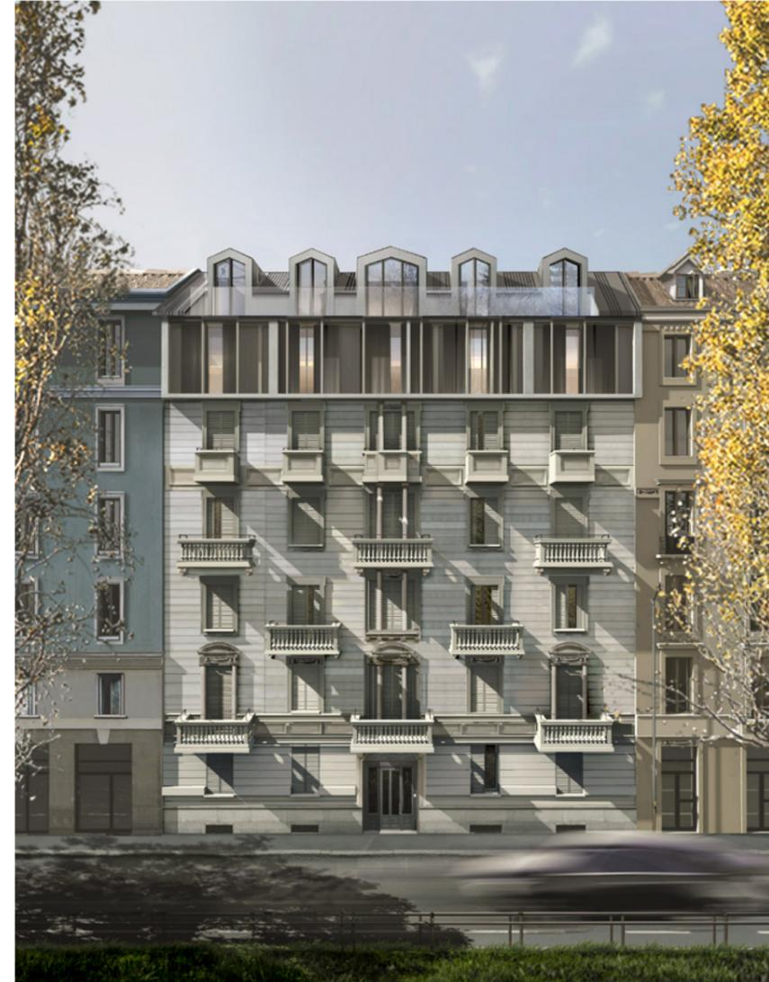
L'INTERVENTO PREVEDE UNA RISTRUTTURAZIONE DELL'EDIFICIO ESISTENTE E UNA SOPRAELEVAZIONE DI DUE LIVELLI.
